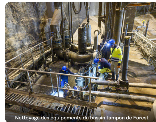
— Inspection et décolmatage des grilles de la fosse des pompes
