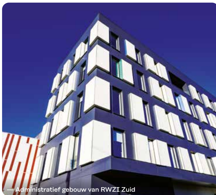
— Administratief gebouw van RWZI Zuid, uitgerust met zonnepanelen
